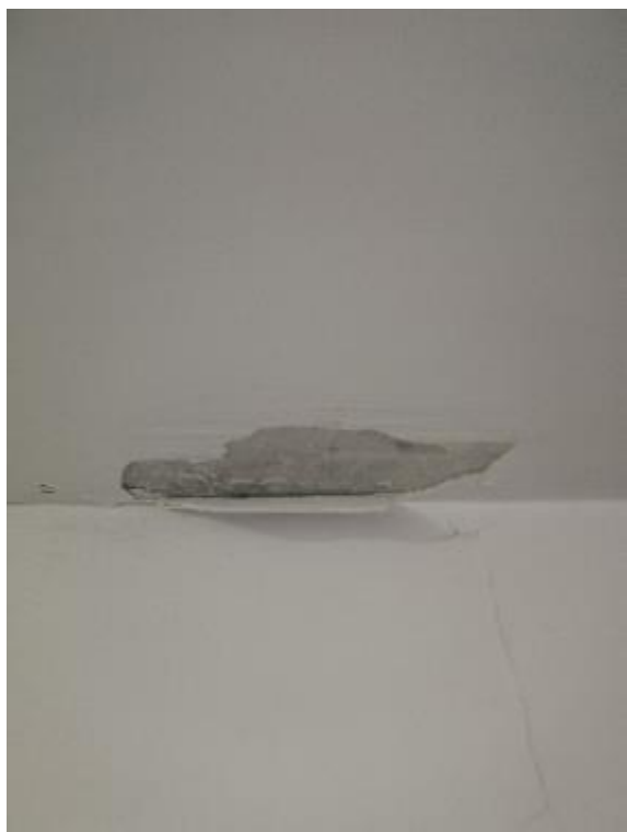
Zdjęcie 6. Przykładowe uszkodzenia sufitów żelbetowych
