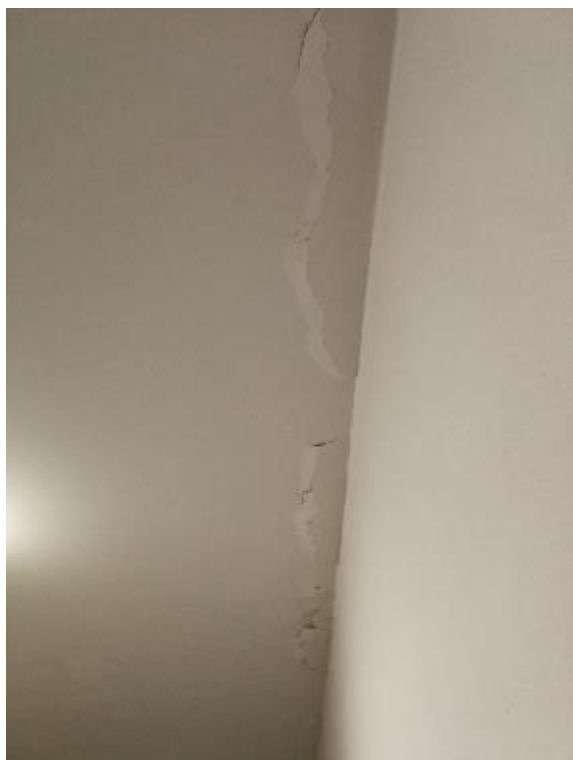
Zdjęcie 8. Przykładowe uszkodzenia sufitów żelbetowych
