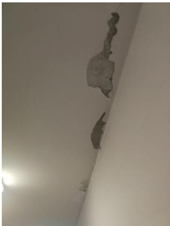
Zdjęcie 8. Przykładowe uszkodzenia sufitów żelbetowych
